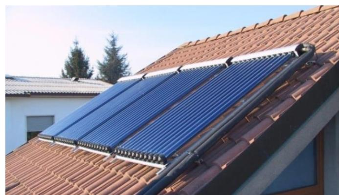
*Slika 2. Solarni kolektor za grijanje vode*
